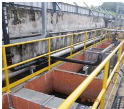
ภาพที่ 7 บ่อดักคราบน้ำมัน (Oil interceptor)
